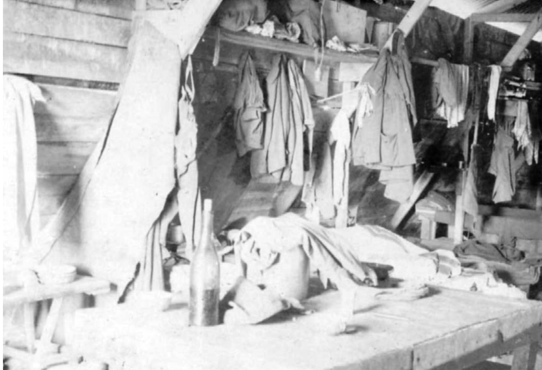
Barracó. Camp de concentració de Saint Cyprien. 1939. Proced.: Sebastià Piera
