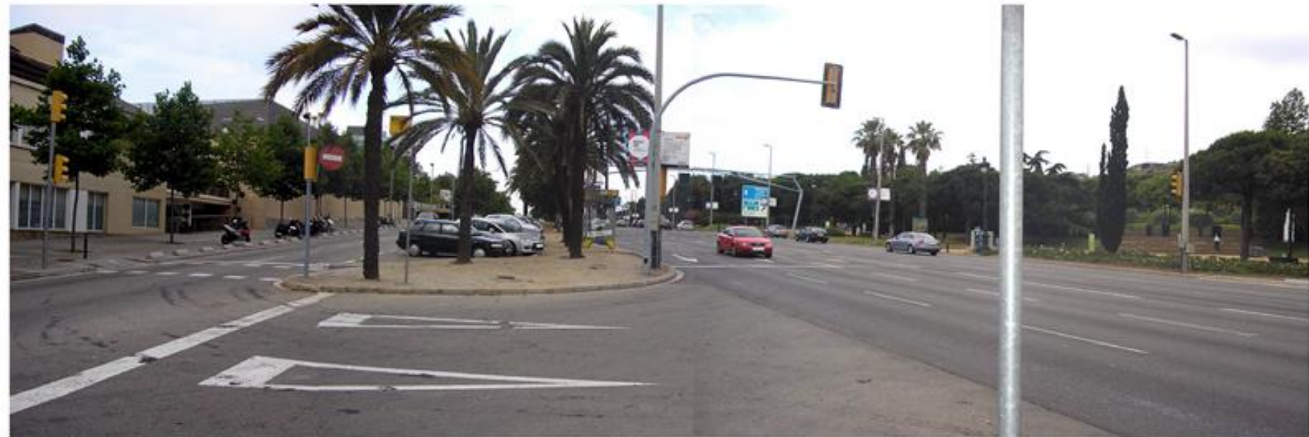
AVINGUDA DIAGONAL INICI B-23 SITUACIÓ ACTUAL
