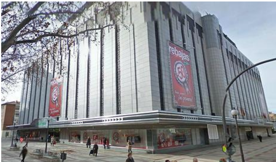
El centro de El Corte Inglés en Valladolid.
