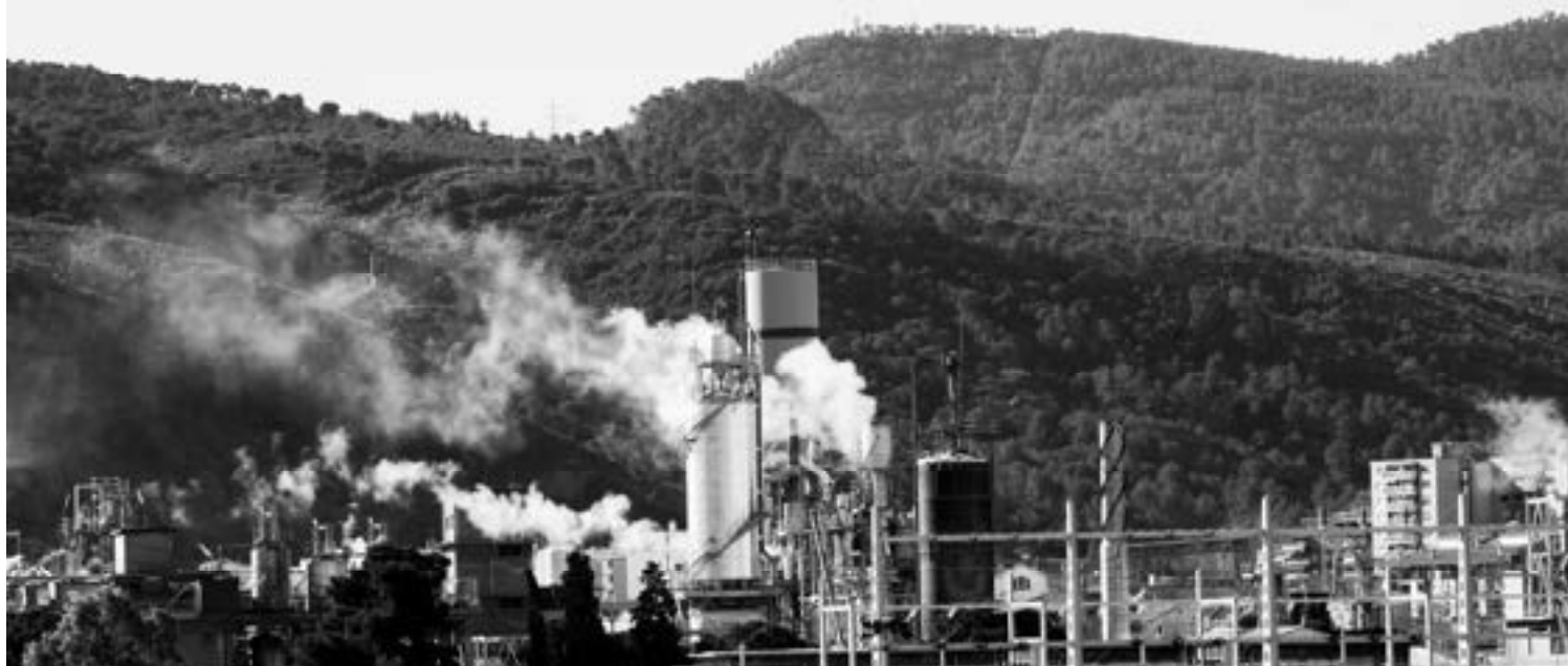
Instal·lacions de Solvay a Martorell / Foto: Iris Martínez
