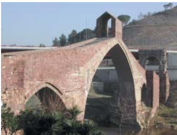
Pont del Diable, reconstrucció feta l'any 1963 sobre una base romana amb tres arcades desiguals.
